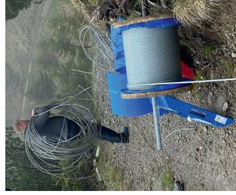
Die alten Seile wurden durch neue, Gummimantelnde Seile ausgetauscht
