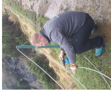
Lex beim Verschrumpfen der Seilenden mit Schrumpfschlauch
