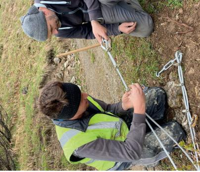
konfektionieren der Seilenden für die Seilspanner
